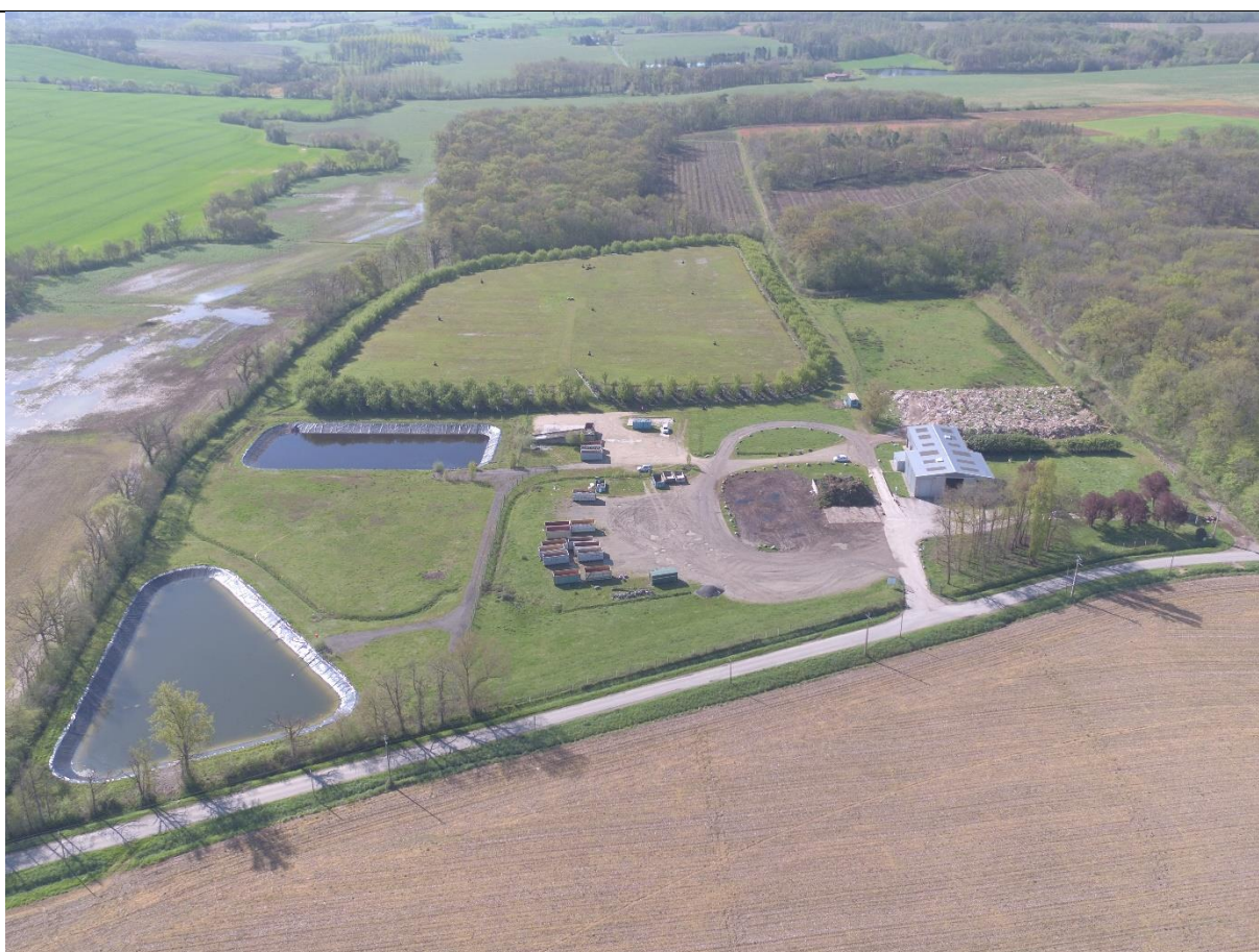
Vue d'ensemble du site (vue vers le Sud – mai 2018)
