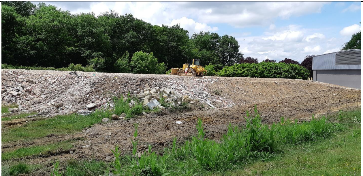
Vue d'ensemble vers le Nord depuis la bordure Est de la zone ISDI (juin 2018)
