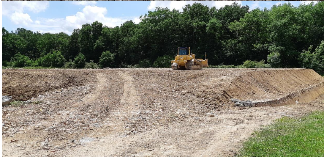
Vue d'ensemble vers le Sud depuis la rampe accès (juin 2018)
